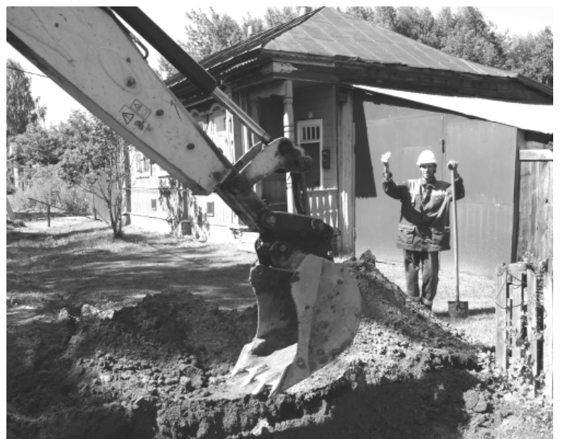
Работы по врезке в газопровод для газификации домовладения в селе Урваново
