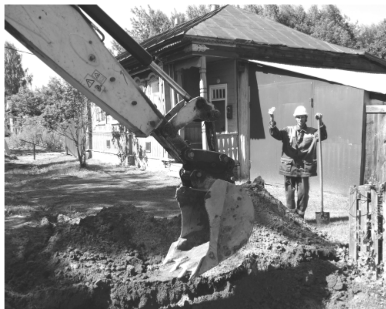
Работы по врезке в газопровод для газификации домовладения в селе Урваново
